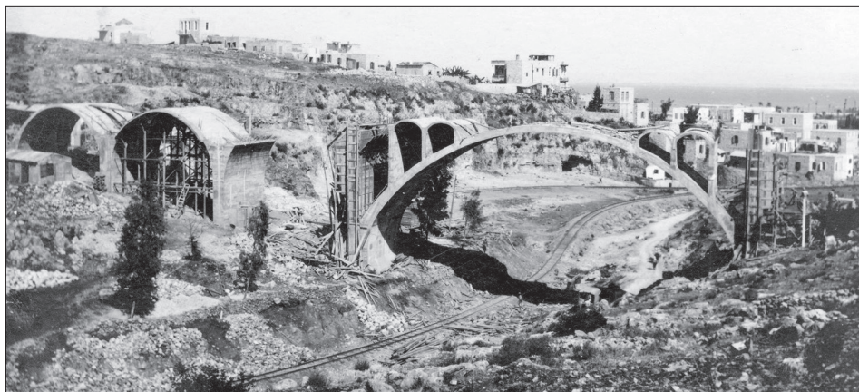
איור 20: פסי הרכבת מתחת לגשר ואדי רושמיה בעת הקמתו (באדיבות מיקי גוטשלק)
